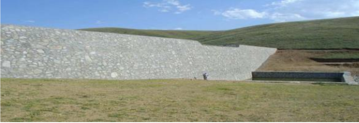
Şekil 4. Düşü havuzlu kargir tersip bendi Kırıkkale, Hasandede-Kaledere (Dinçsoy, 2008)
