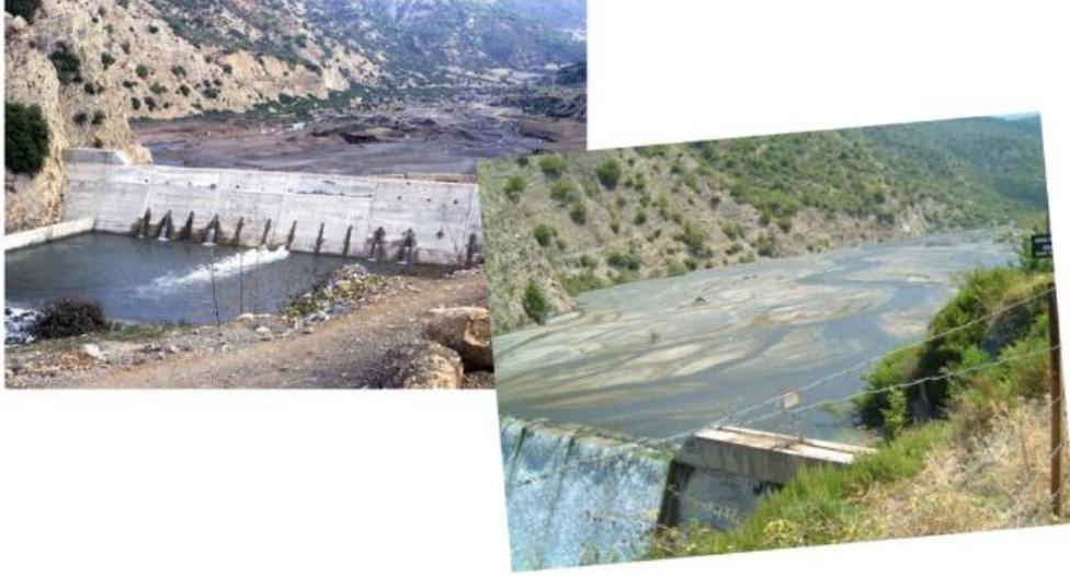
Şekil 8. Rezervuarı dolmuş tersip bendi (URL 1)
