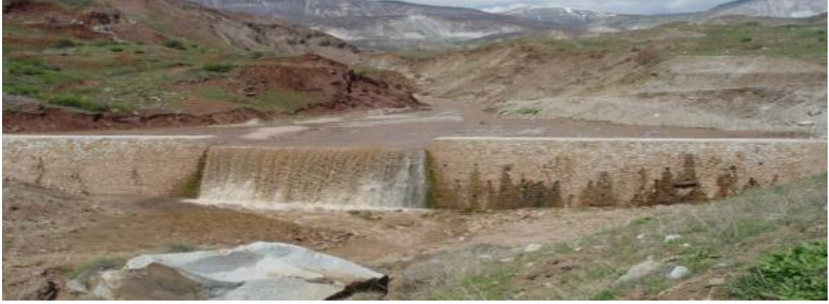
Şekil 3. Kargir ıslah sekisi Sivas Suşehri Çamlığöze Barajı, Uludere (Dinçsoy, 2008)
